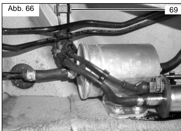
Montage - Brennstoffleitung (Abb. 66)
